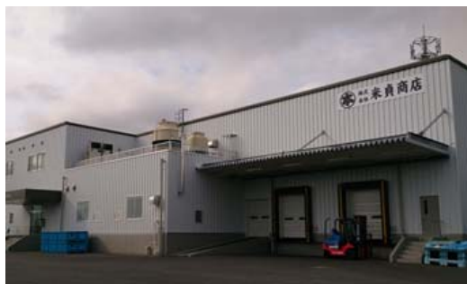
平成26年5月に竣工した新工場の外観
